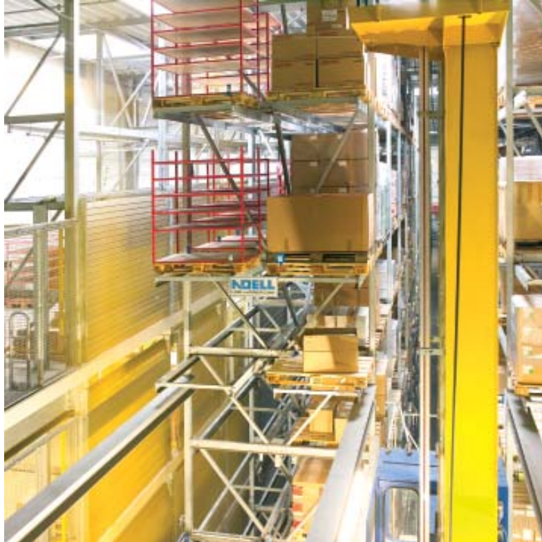
Mit 10 Gassen und 24.000 Palettenplätzen gut gerüstet für die Zukunft
